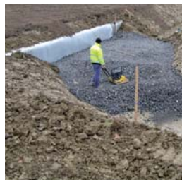
Gut gedämmt und statisch entlastet: Leichtschüttung mit GEOCELL Schaumglasschotter
