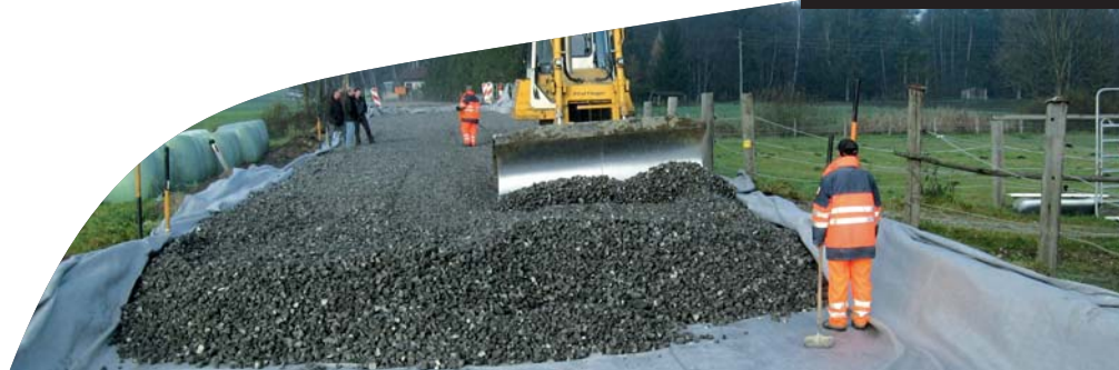
Belastbarer Untergrund: GEOCELL Schaumglasschotter bildet die Tragschicht der in einem Moorgebiet befindlichen Hölzöster Landesstraße L1010
