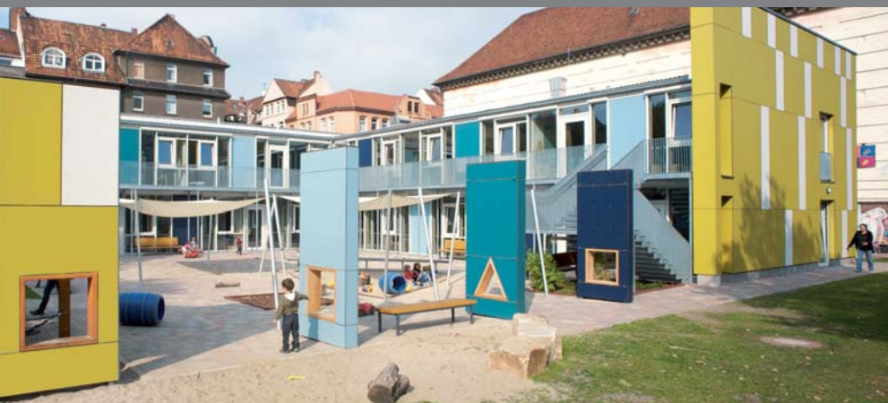
GEOCELL erfüllt spielend die Wärmeschutzanforderungen für Passiv-Kindertagesstätte
