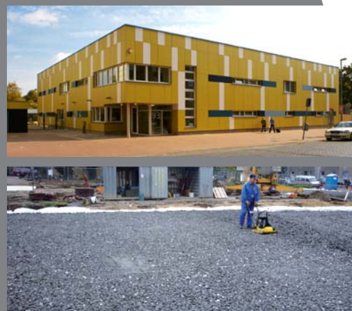
30 cm GEOCELL verdichtet 1,3:1
