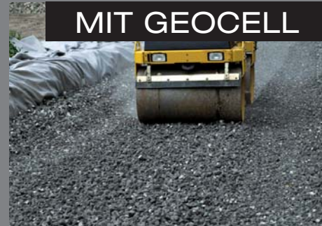
Verdichten von GEOCELL mit einer Straßenwalze in Oldenburg
