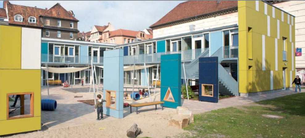
GEOCELL erfüllt spielend die Wärmeschutzanforderungen für Passiv-Kindertagesstätte
