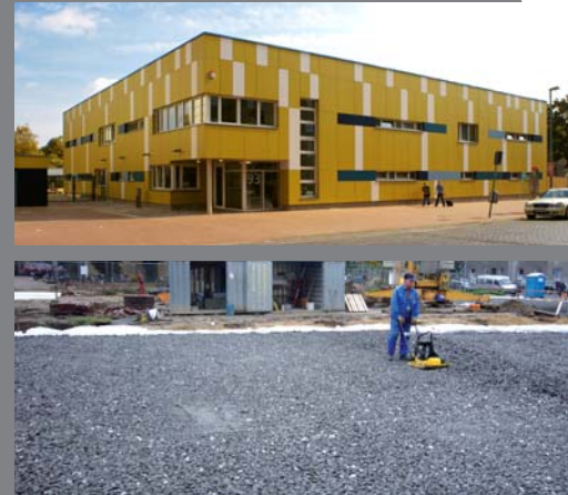
30 cm GEOCELL verdichtet 1,3:1
